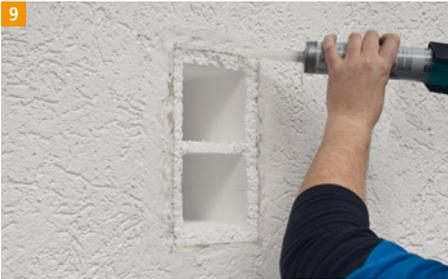
Zum Schutz vor Wassereintritt in den Wanddurchbruch dichten Sie den fassadenseitigen Übergang zur Wanddurchführung **umlaufend** mit einem geeignetem Dichtmaterial ab.
