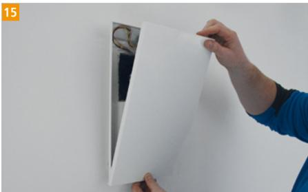
Verschließen Sie die Außenhaube (Wetterschutzhaube) und sichern diese mit der Befestigungsschraube an der Oberseite.
