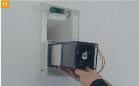
Montieren Sie die Konsole der Designblende mit geeigneten Befestigungselementen mit der Geräteelektronik nach oben. Schieben Sie die Ventilatoreinheiten (Ventilator zeigt Richtung Raum) vorsichtig in die Wanddurchführung ein.
