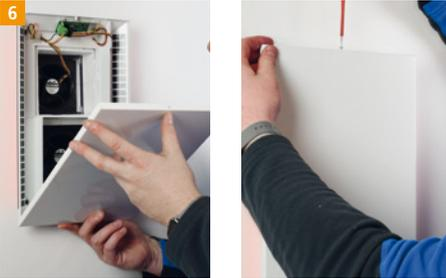
Montieren Sie die Innenblende der **AIRUNIT GEMINI** Lüftungseinheit.
