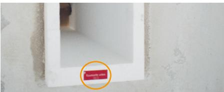
Alle Wanddurchführungen sind zur Ableitung von Kondensat mit integriertem Gefälle nach außen gefertigt (Markierung für die Raumseite beachten, siehe Abb. links).
