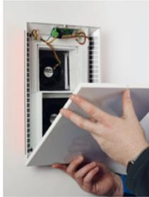
Demontieren Sie die Innenblende der **AIRUNIT GEMINI** Lüftungseinheit (siehe Kap. **Übersicht AIRUNIT GEMINI**, Buchstabe G).
