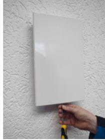
Montieren Sie die Außenhaube (Wetterschutzhaube) der **AIRUNIT GEMINI** Lüftungseinheit (siehe Kap. **Übersicht AIRUNIT GEMINI**, Buchstabe K).
