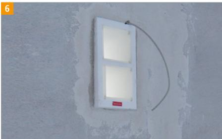
Führen Sie die Anschlussleitung (min. J-Y(ST)Y 2x2x0,6 mm<sup>2</sup>) oberhalb (rechts / Ansicht Raumseite) in die Wanddurchführung ein.
