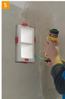
Schieben Sie die Wanddurchführung in den Wanddurchbruch ein und lassen Sie die Wanddurchführung bei Bedarf (z.B. für weitere Putz- oder Dämmschichten) entsprechend raum- und fassaden-seitig überstehen.
