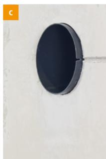
Schieben Sie die Wanddurchführung in die Kernlochbohrung ein und lassen Sie die Wanddurchführung bei Bedarf (z.B. für weitere Putz- oder Dämmschichten) entsprechend raum- und fassadenseitig über stehen.
