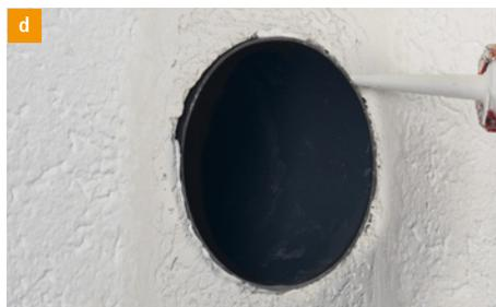
Dichten Sie die Wanddurchführung zum Mauerwerk innen und außen mit einer geeigneten Dichtmasse ab.
