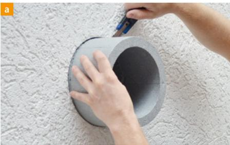
Nach Abschluss der Dämm- / Putzarbeiten entfernen Sie die Putzdeckel auf der Innen- und Außenseite. Passen Sie die Wanddurchführung dem Maß der Fertigwand an, indem Sie die Wanddurchführung mit einem Teppichmesser oder einem Heißdraht **raum- und fassadenseitig wandbündig** kürzen.
