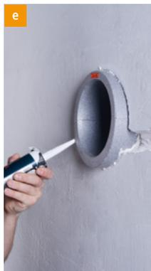
**Achtung!** Um eine spannungsfreie Montage / Demontage (Wartung) des Ventilators / des Wärmespeichers in der Wanddurchführung sicherzustellen, sind Verformungen der Wanddurchführung durch äußeren Druck / Verspannung zu vermeiden! Achten Sie stets darauf, dass die Wanddurchführung mit einem Gefälle nach außen montiert wird.
