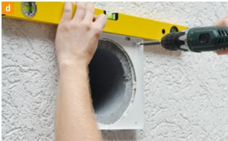
Montieren Sie die Wandkonsole der Wetterschutzhaube mit geeigneten Befestigungselementen.
