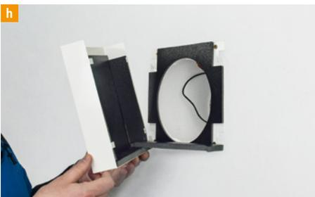
Führen Sie die Abdeckung über die Wandkonsole, sodass die Befestigungslaschen in die Aussparungen greifen.
