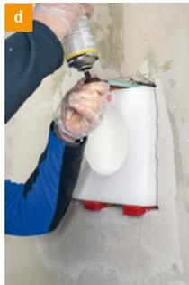
Mauern Sie die Wanddurchführung ein und lassen Sie diese bei Bedarf (z.B. für weitere Putz- oder Dämmschichten) entsprechend raum- und fassadenseitig über stehen. Alternativ können Sie die Wanddurchführung in einen Wanddurchbruch montieren. Lassen Sie auch hier die Wanddurchführung bei Bedarf (z.B. für weitere Putz- oder Dämmschichten) entsprechend raum- und fassadenseitig über stehen.
