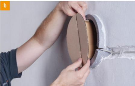
Verschließen Sie die Wanddurchführung auf der Innen- und Außenseite mit den mitgelieferten Putzdeckeln, um eine Verschmutzung der Wanddurchführung zu vermeiden.
