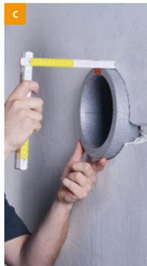
Schieben Sie die Wanddurchführung in die Kernlochbohrung ein und lassen Sie die Wanddurchführung bei Bedarf (z. B. für weitere Putz- oder Dämmschichten) entsprechend raum- und fassadenseitig über stehen. Beachten Sie das **Gefälle nach außen** bzw. die **raumseitige Markierung** der Wanddurchführung.
